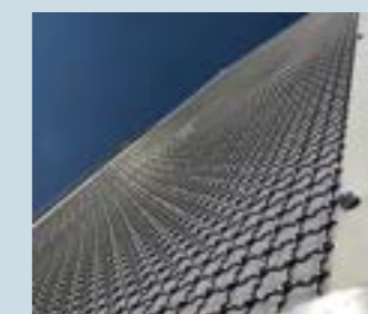
Griglia d'acciaio fissata sul lucernario piramidale
