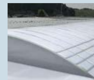
Fasce d'alluminio fissate sulla volta
