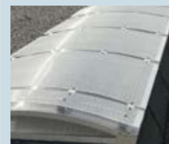
Lamiera perforata fissata sulla volta
