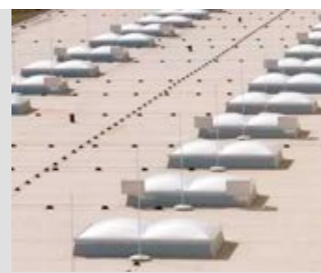
Fabbrica e magazzino Valore U da 2,0 a 1,3 W/m²K Cupola da 2 a 3 strati
